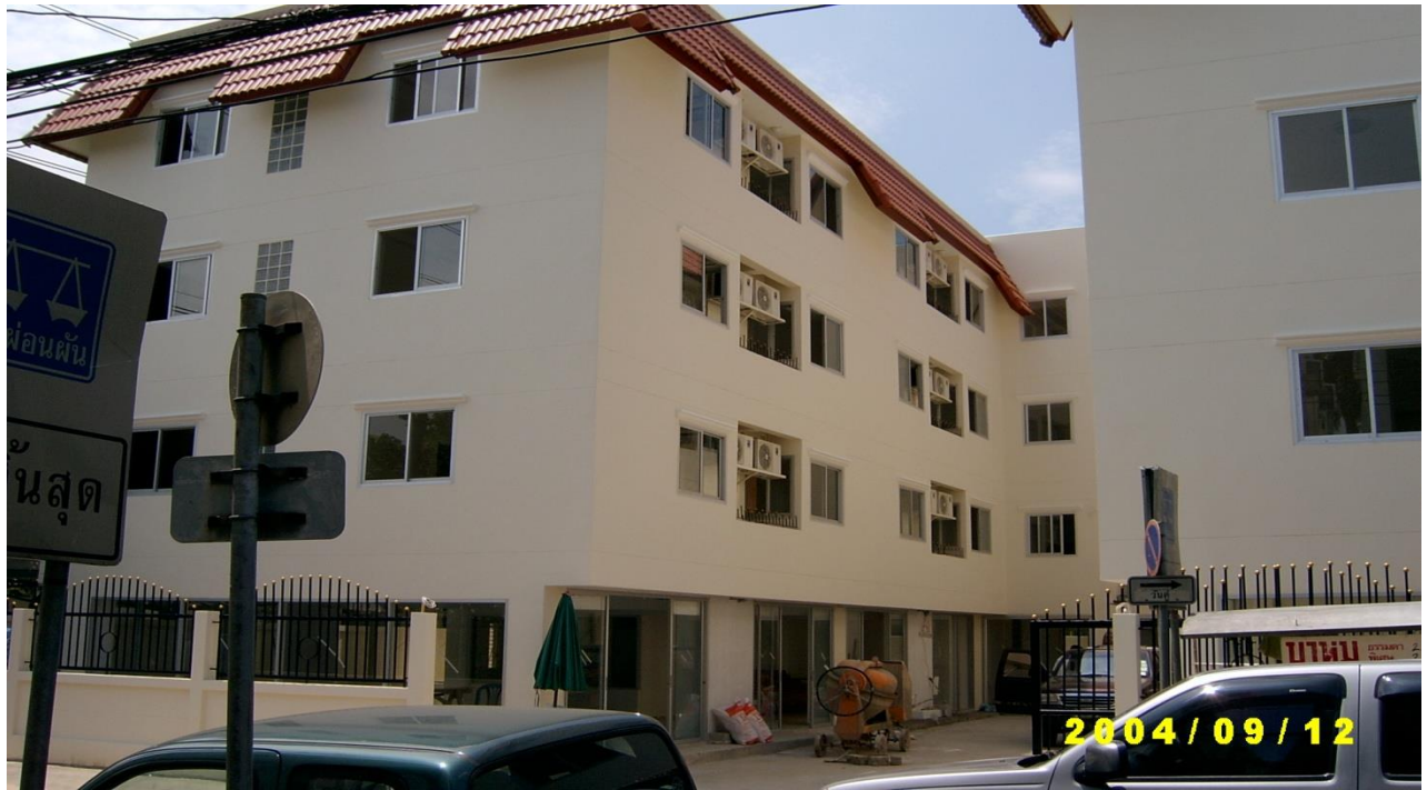
อาคารหอพัก คสล. 4 ชั้น จำนวน 2 หลัง ซ.สวนอ้อย เขตดุสิต กรุงเทพฯ
