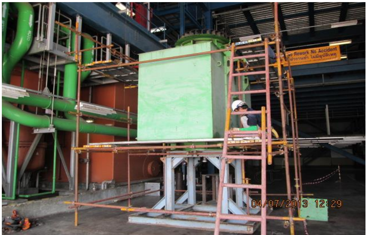
ติดตั้งน้ํารองโรงไฟฟ้าต่าง ทั้งภายนอกและภายในโรงไฟฟ้า
