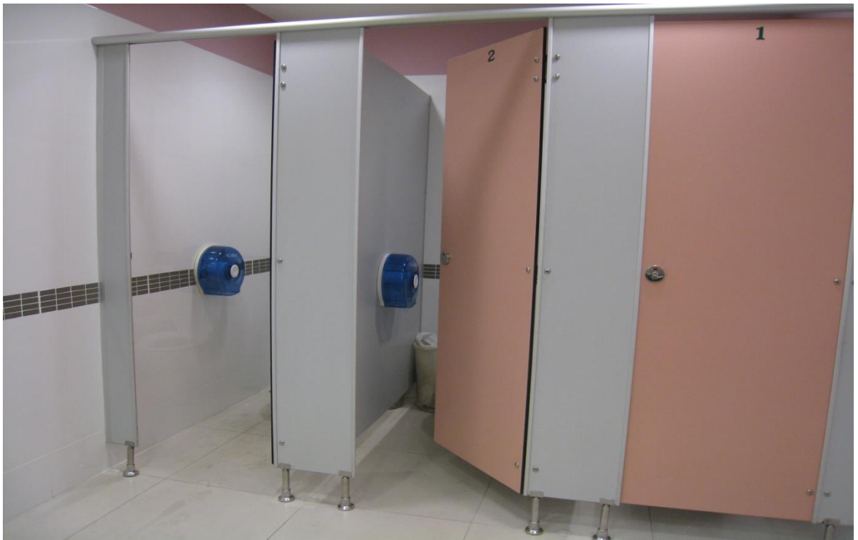
งานปรับปรุงห้องน้ำเทสโก้โลตัส สาขาบางแค , พัทยาเหนือ , ชีคอนสแควร์
