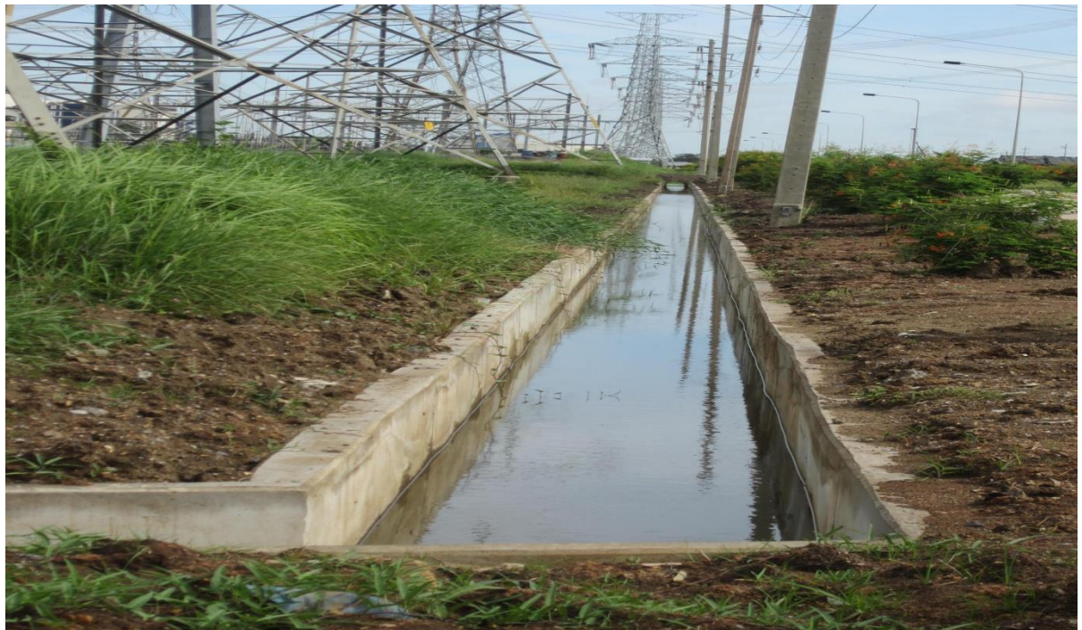
รางระบายน้ำโรงไฟฟ้าวังน้อย
