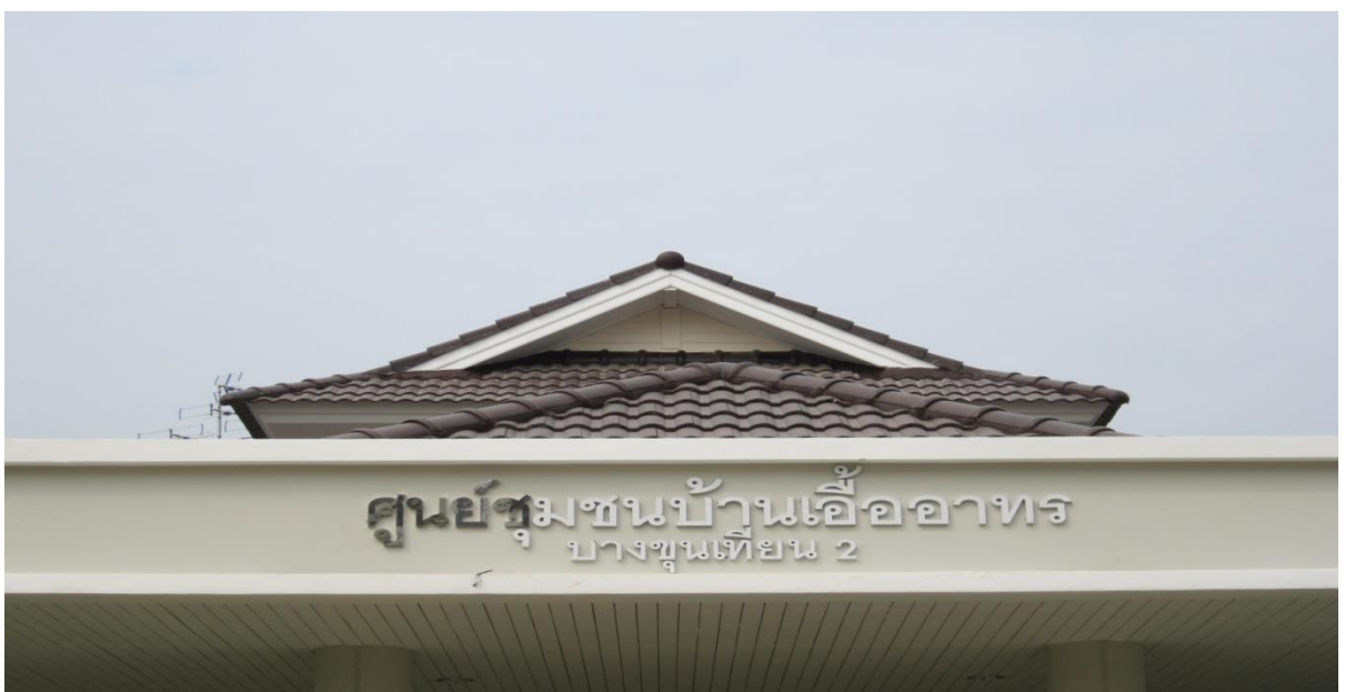
ก่อสร้างโครงการศูนย์ชุมชนบ้านเอื้ออาทร ด้วยการเคหะแห่งชาติ กทม.
