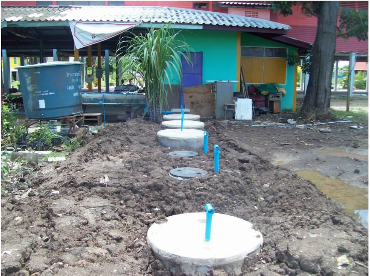
งานก่อสร้างระบบบำบัดน้ำเสียเบื้องต้นจากโรงอาหารของจังหวัดพระนครศรีอยุธยา จำนวน 10 แห่ง
