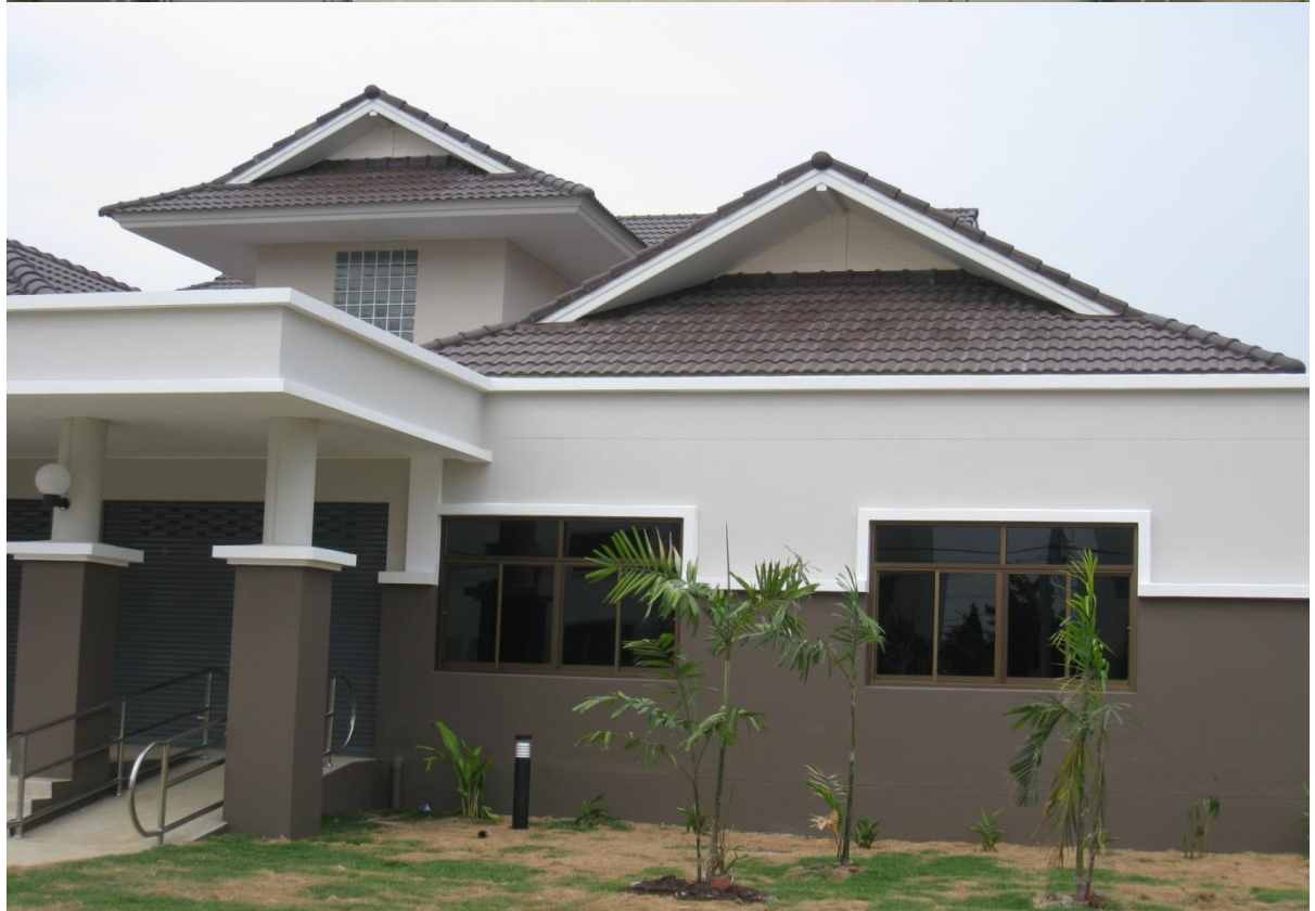
ก่อสร้างโครงการศูนย์ชุมชนบ้านเอื้ออาทร ด้วยการเคหะแห่งชาติ กทม.
