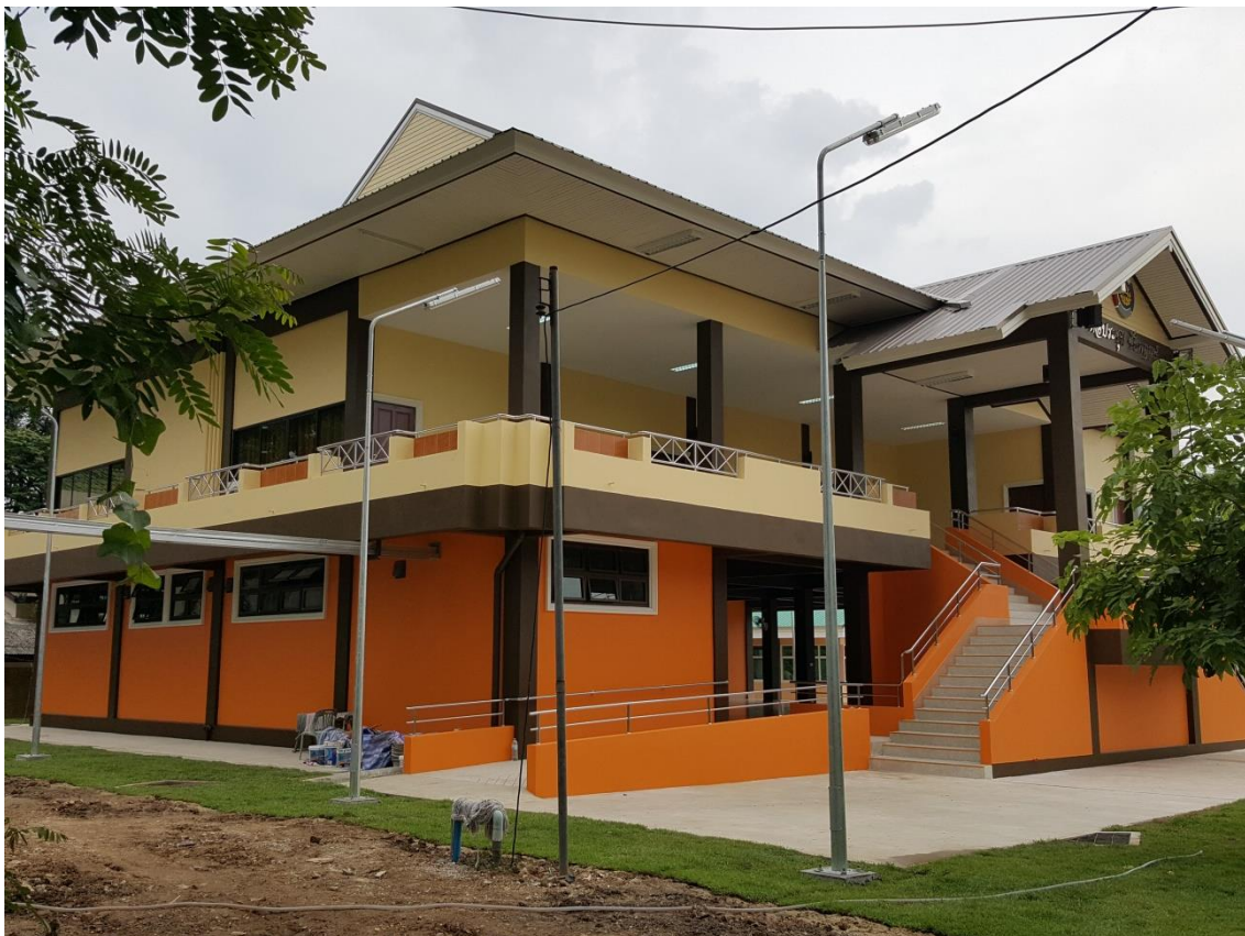
งานก่อสร้างอาคารหอประชุม ขนาด 250 ที่นั่ง ณ ศูนย์ศึกษาพัฒนาห่มชนสระบุรี
