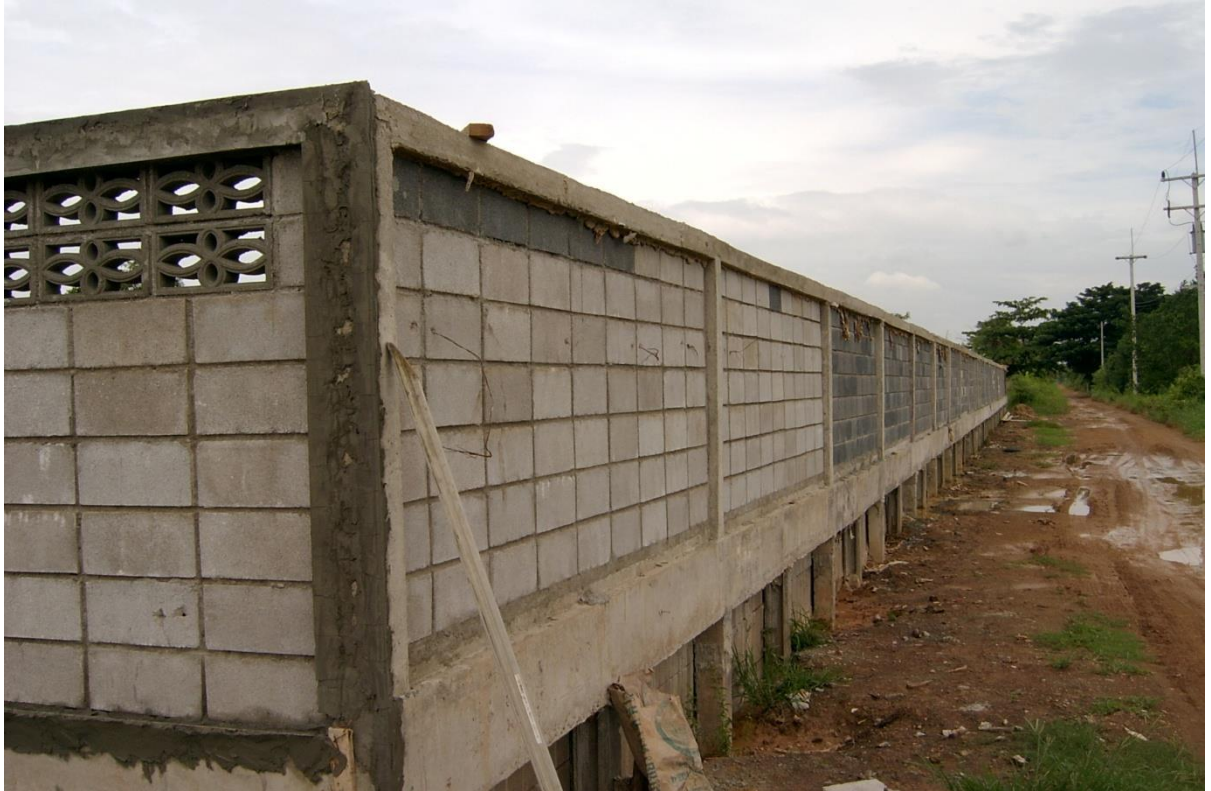
ก่อสร้างรั้วและซุ้มประตูโรงเรียนราชวินิตบางแคปานขำ กทม.
