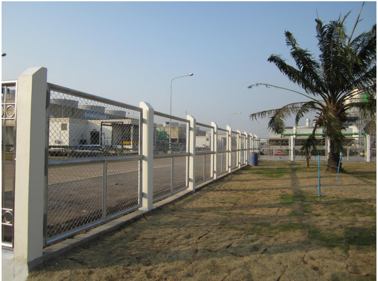
งานก่อสร้างรั้วตาข่ายกันเขตพื้นที่ โรงไฟฟ้าวังน้อย จ.พระนครศรีอยุธยา
