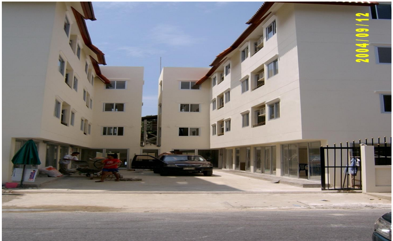
อาคารหอพัก คสล. 4 ชั้น จำนวน 2 หลัง ซ.สวนอ้อย เขตดุสิต กรุงเทพฯ
