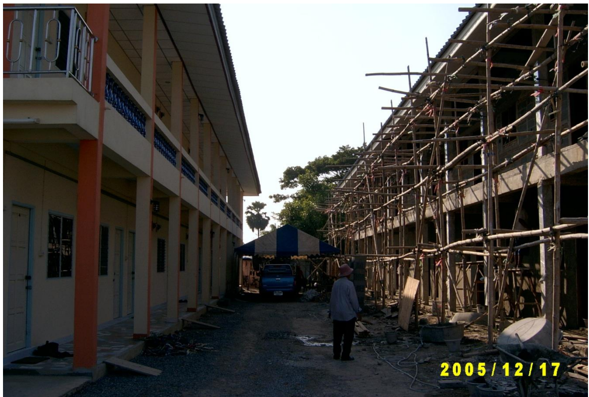
อาคารหอพัก คสล.2 ชั้น อ.บางปะอิน จ.พระนครศรีอยุธยา
