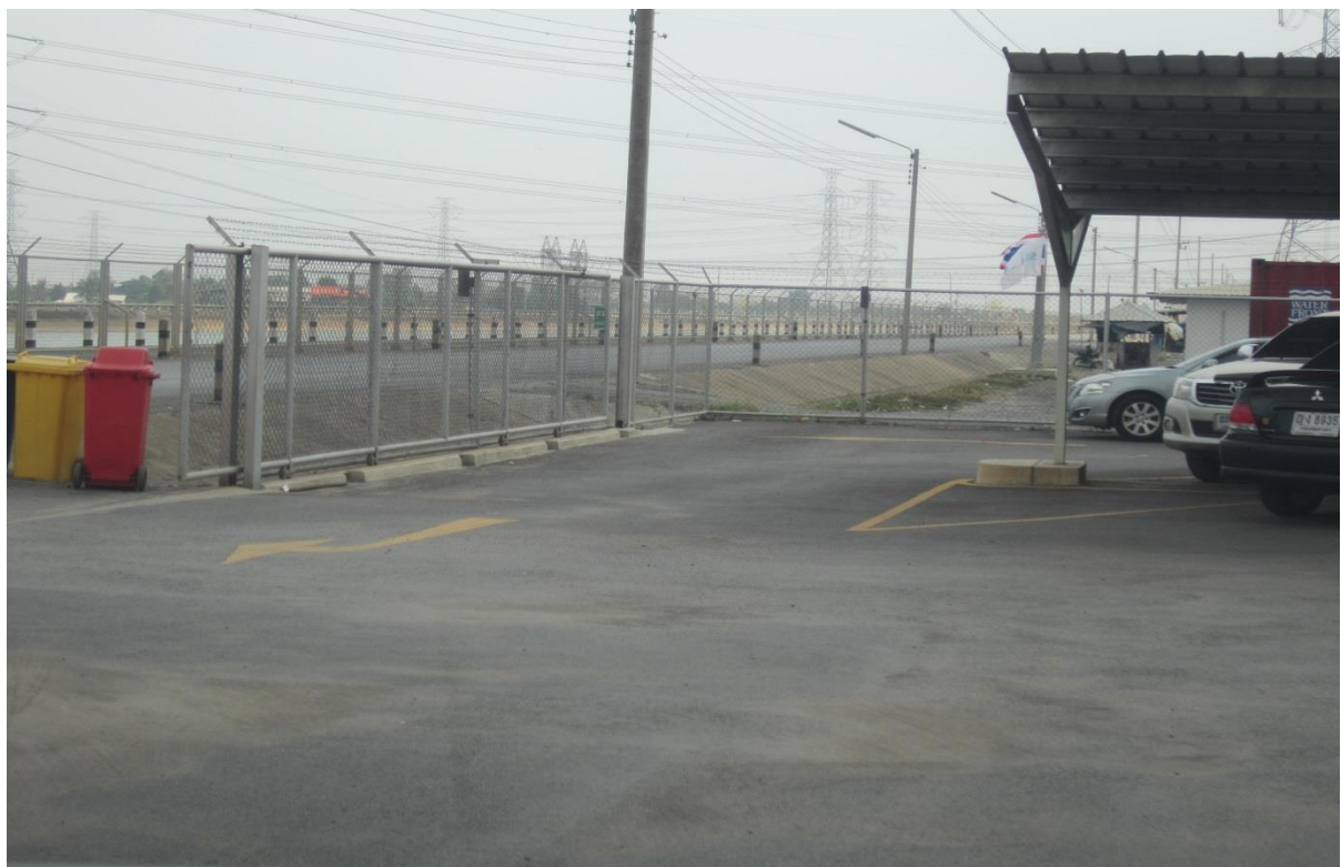
งานก่อสร้างปูผิว ASPHALTIC CONCRETE ลานจอดรถพร้อมดีเอ็นจราจรหน้าสำนักงานโครงการ ก่อสร้างโรงไฟฟ้าวังน้อย Block 4
