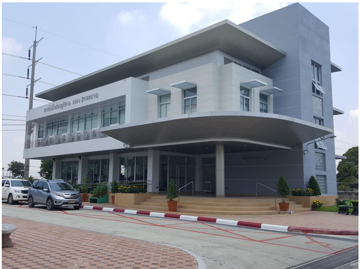
งานก่อสร้างอาคารสำนักงาน ถนน-ลาน ภายในการไฟฟ้าส่วนภูมิภาค เขต 1(ภาคกลาง) จ.พระนครศรีอยุธยา
