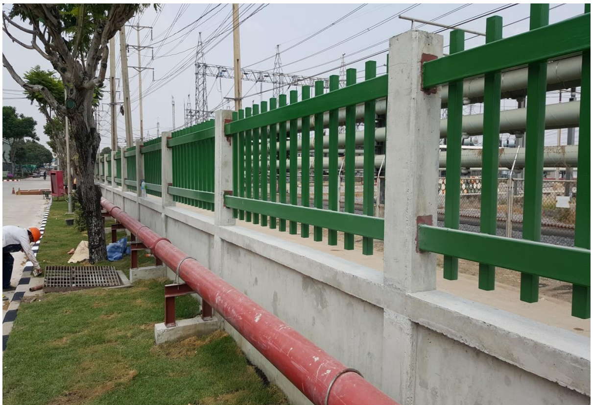
งานก่อสร้างรั้วคอนกรีตเสริมเหล็ก รอบพื้นที่กองโรงงาน ฝ่ายโรงงานและอะไหล่ (หนองจอก) การไฟฟ้าฝ่ายผลิตแห่งประเทศไทย
