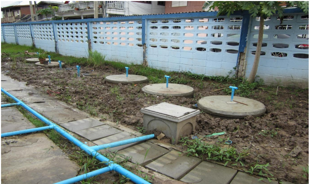
งานก่อสร้างระบบบำบัดน้ำเสียเบื้องต้นจากโรงอาหารของจังหวัดพระนครศรีอยุธยา จำนวน 10 แห่ง
