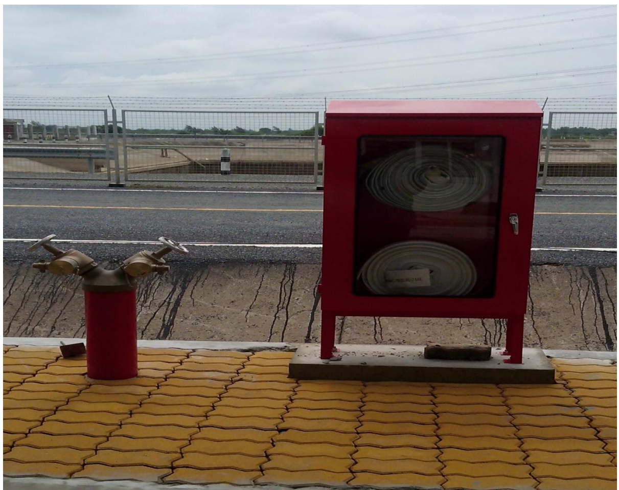
งานก่อสร้างระบบดับเพลิงโครงการพัฒนา โรงไฟฟ้าวังน้อย ชุดที่ 4 จ.พระนครศรีอยุธยา
