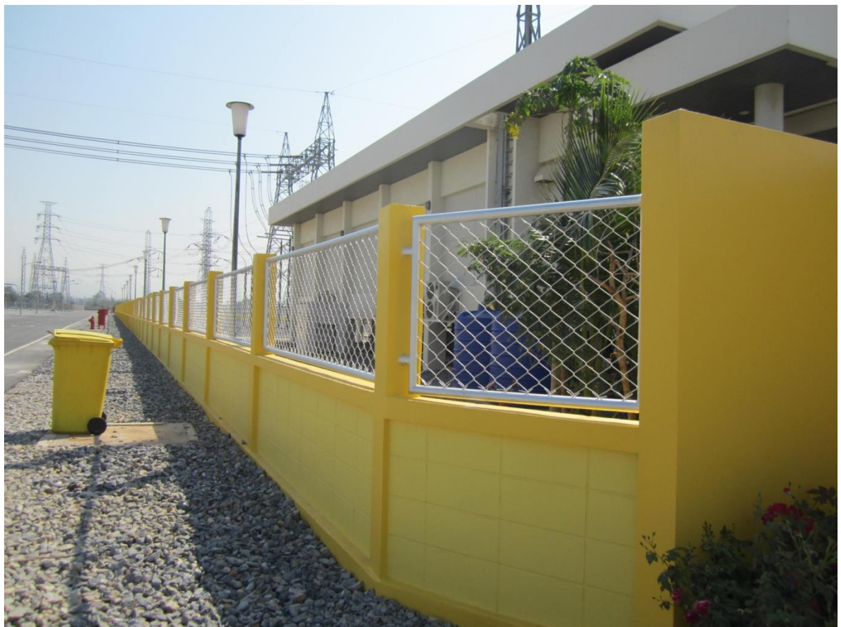
งานก่อสร้างรั้วคอนกรีตบล็อกครึ่งหนึ่งลดตาข่ายครึ่งหนึ่ง ความยาว 636 เมตร สถานีไฟฟ้าแรงสูงแก่งคอย จ.สระบุรี
