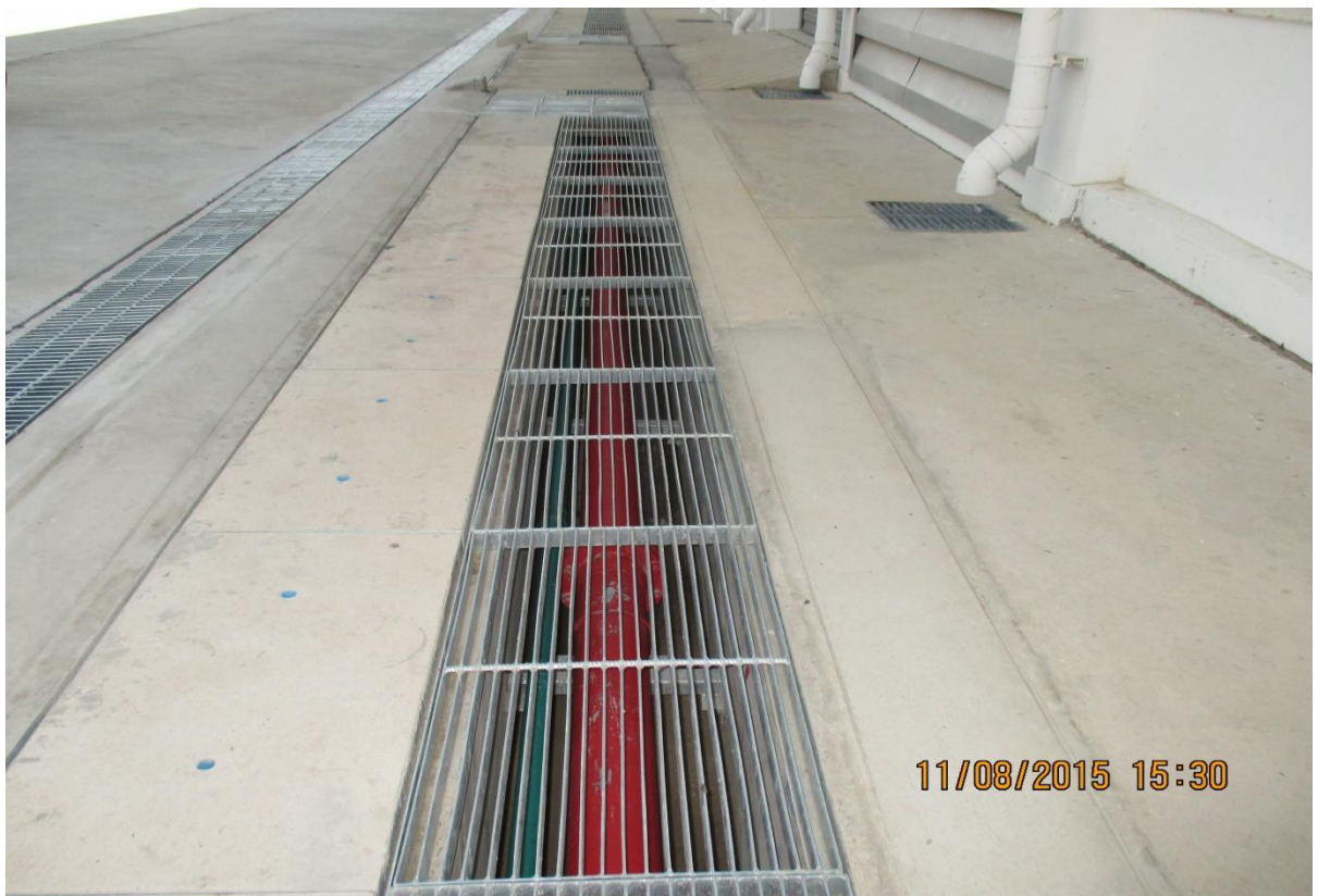
งานก่อสร้างราง Pipe Trench โครงการพัฒนา โรงไฟฟ้าวังน้อย ชุดที่ 4 จ.พระนครศรีอยุธยา
