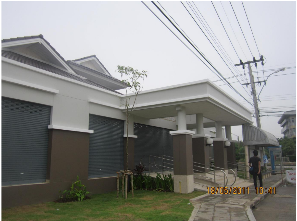
ก่อสร้างโครงการศูนย์ชุมชนบ้านเอื้ออาทร ด้วยการเคหะแห่งชาติ กทม.
